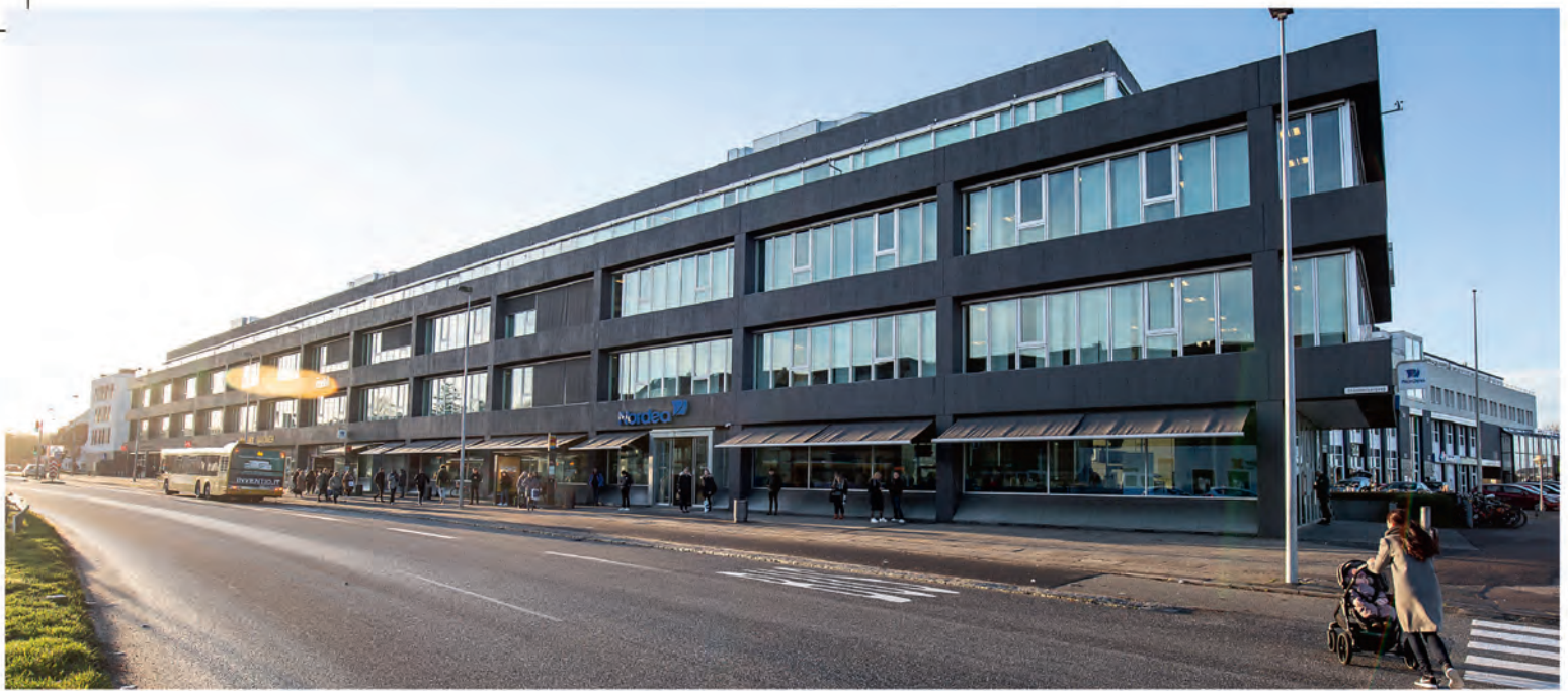
Kontorsbyggnaden i stadsdelen Viby i utkanten av Århus.
