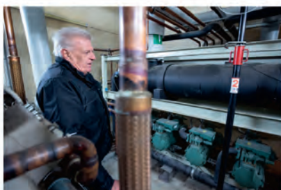
Varuhusets gamla R134a-maskin finns kvar i och kan användas som back-up om det skulle bli en kritisk spetsbelastning. På bilden Klaus Kilstoft.
