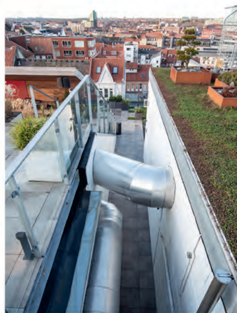
Nya rör har dragits för till- och frånluften i varuhusets installationsanläggning.
