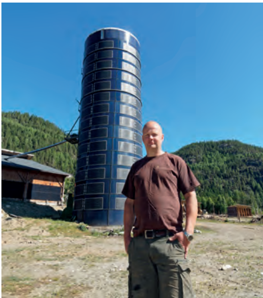
Siloen er dekket med solceller fra øverst til nederst.
