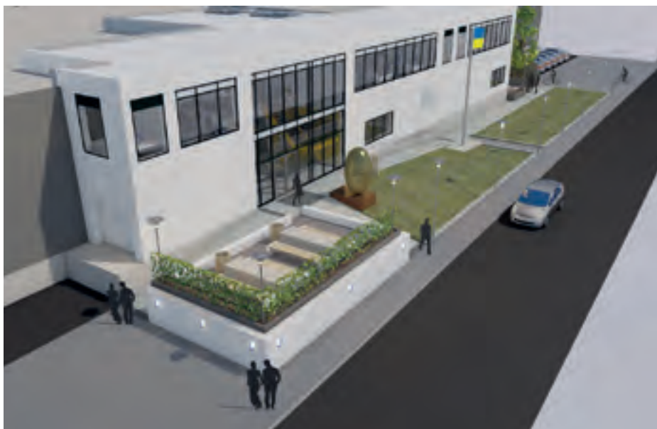
Dette er det nye rugeriet når det står ferdig.
